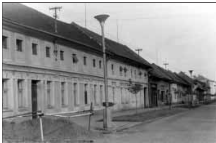
celkový pohled na domy č.p. 47 – 50 (v obráceném pořadí) před zbouráním a výstavbou nových budov
