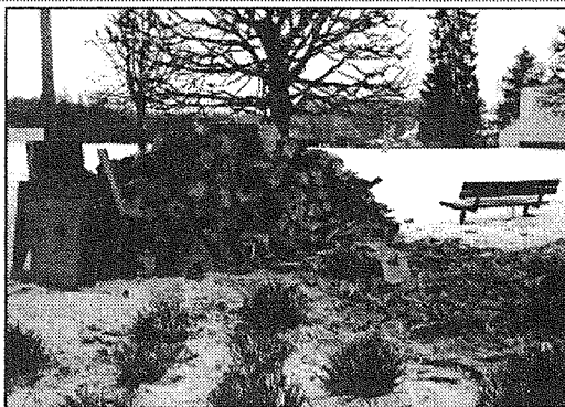
Hromádka trouchnivého dřeva svědčí o stavu krovů střechy kostela
