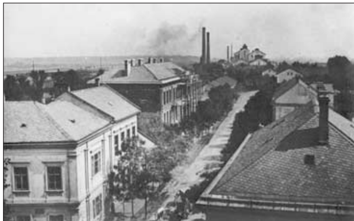
výstavba nové budovy školy na Komenského ulici
