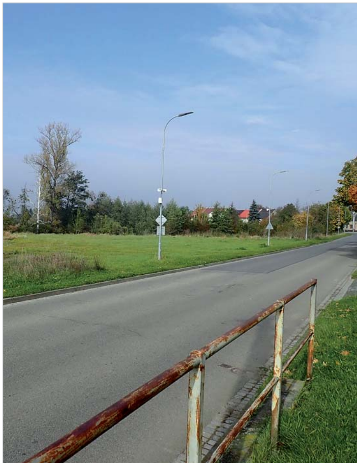
Příprava výstavby nového bydlení v ulici U Hejtmána pomalu postupuje vpřed.
