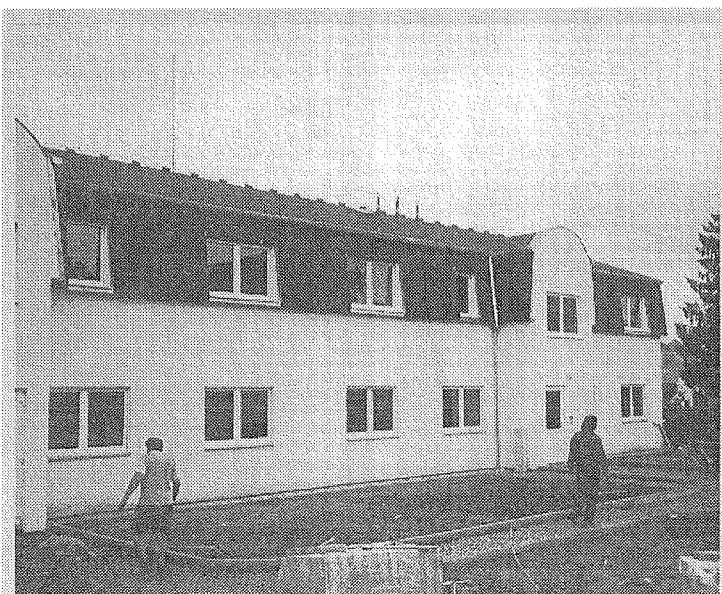
Dům na Hrázkách je hotov, zbývá dokončit exteriér.
