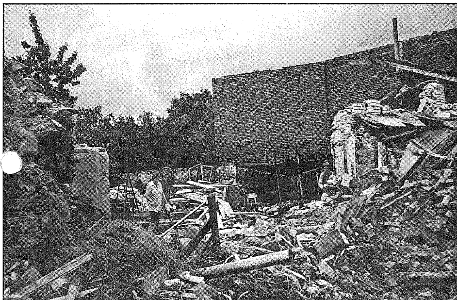
Zbourání poškozených objektů je prvním krokem k jejich opětovnému vybudování.
