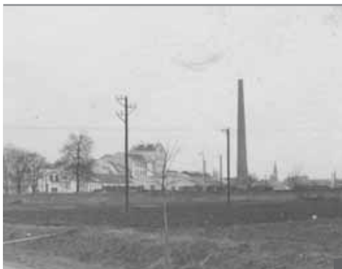
r. 1958 – již chemická továrna – foto z části Drahy.
