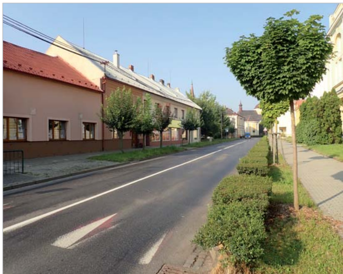
Připravuje se rekonstrukce chodníku od kostela k restauraci U Rybníka
