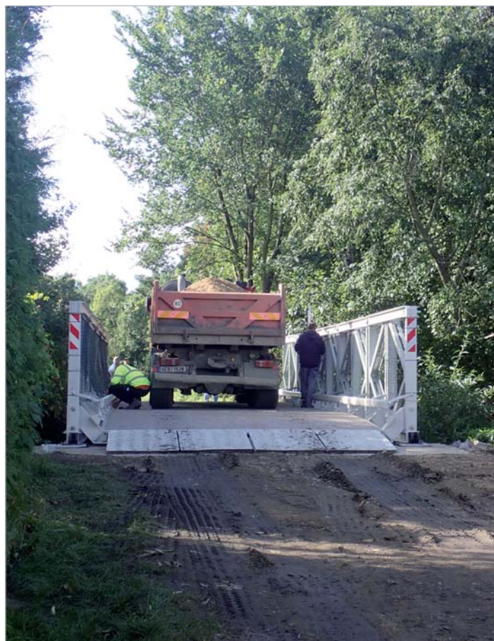
Ocelový most se po celkové a tolik potřebné rekonstrukci vrátil na své místo.
