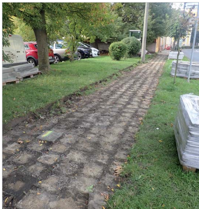
Probíhající oprava chodníku na ulici Komenského nezůstane sama, naváže na ni oprava parkovací plochy mezi farou a sokolským stadionem, i parkoviště u bývalé SMM.
