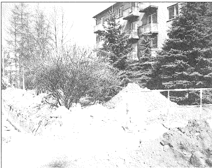
Takto rozkopané sídliště bylo nezbytnou nutností k provedení rekonstrukce rozvodů tepelné energie.
