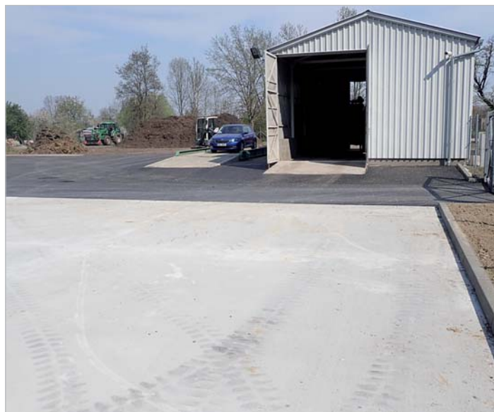
Nově zpevněná plocha kompostárny
