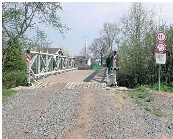
Oprava železného mostu v zahrádkářské kolonii
