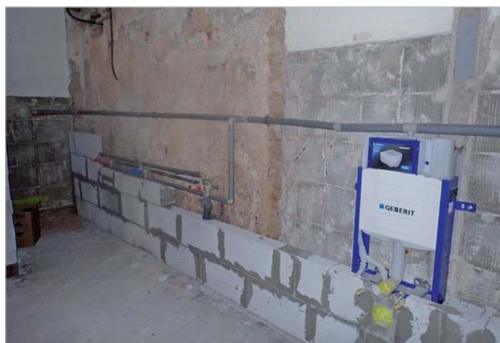
Nově budované toalety
