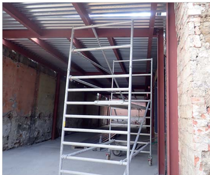
Nově vybudovaná střecha nad přísálím – pohled z archivu
