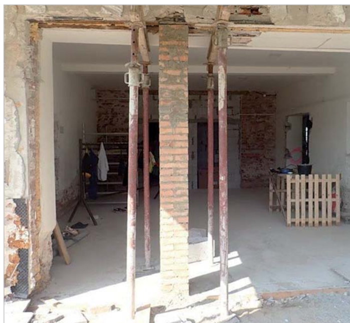
Pohled do MKS po vybourání okna a dveří v hlavním vstupu
