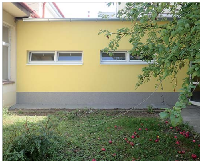
Spojovací chodba mezi základní školou a jídelnou
