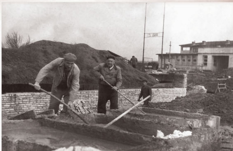
V roce 1959 začala výstavba tělocvičny TJ, která pokračovala v tzv. „akci Z“ i v roce 1960.
