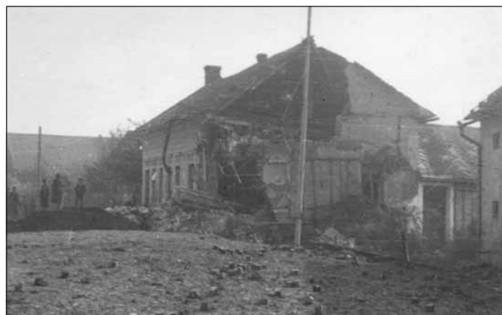
dům dr. Hubíka po vyhození mostu u dnešní knihovny na Masarykově ulici
