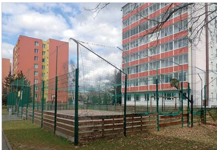
Toto hřiště ve vnitrobloku opravu opravdu potřebuje.
