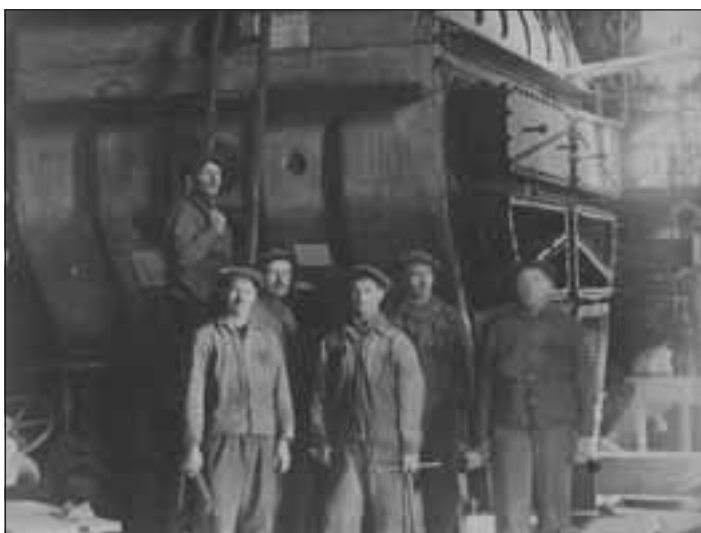
Cukrovar, r. 1920 – demontáž starých Robertů, používaných na svařování cukroviny, místo nich byla dána vakua na surovárnu.
