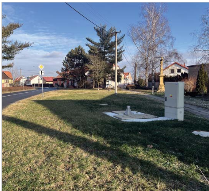
1. Demolice a výstavba nové kanalizační přečerpávací stanice Plešovec – střed. Celkové náklady projektu, který byl realizován bez finanční podpory ve formě dotací, činily 3.190.647 Kč.
