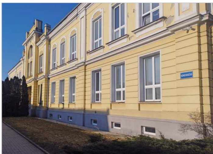
4. Výměna oken Základní školy Chropyně, budova ul. Komenského. Za cenu 2.397.836 Kč jsme zvýšili energetickou účinnost a zlepšili prostředí pro naše školáky. Také bez využití dotace.
