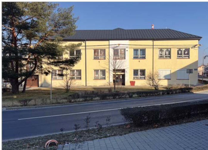
3. Oprava střechy Střediska volnočasových aktivit Chropyně. Náklady na tuto nezbytnou opravu dosáhly 6.063.085 Kč, opět bez využití dotací.
