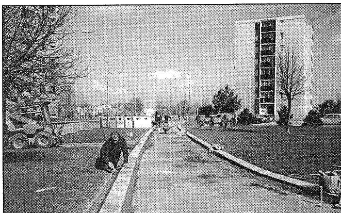
Teplé dubnové počasí dovolilo firmě DLAŽBA provést rekonstrukci vadných chodníků na sídlišti.
