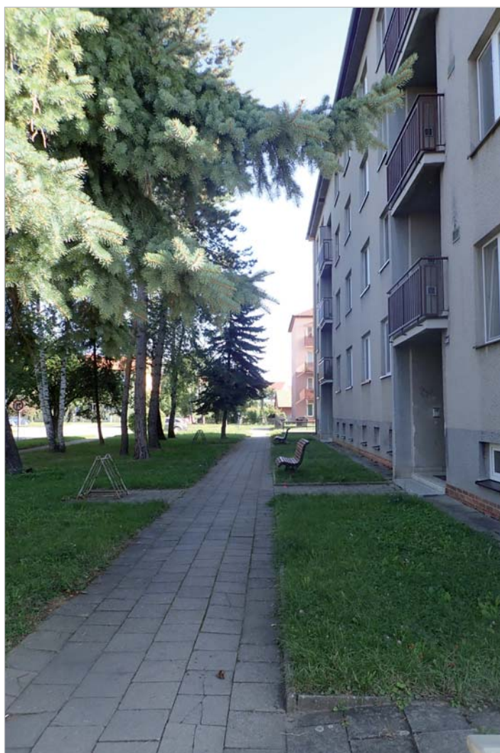
I chodník před domem 629–629 na ulici Tyršova se dočká opravy
