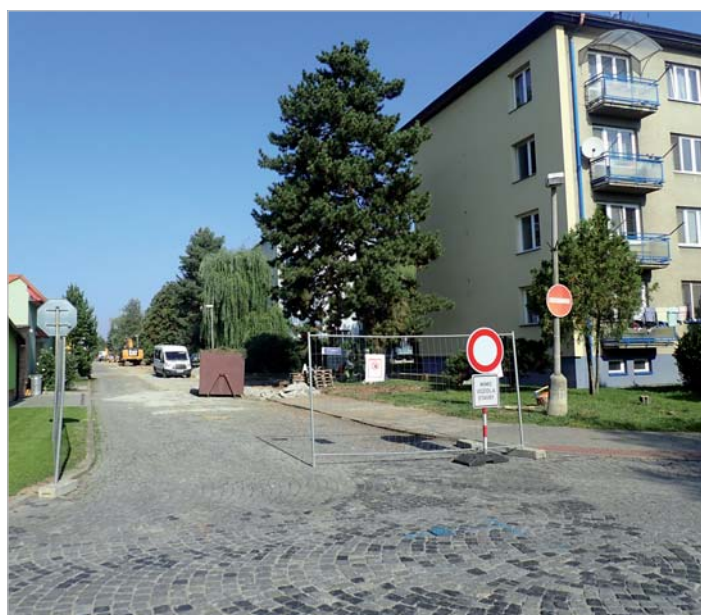
Probíhající regenerace na ulici Díly
